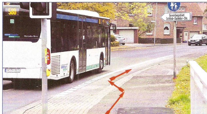
Degerser Straße: Gefährliche Überleitung auf die Fahrbahn im Versatz
