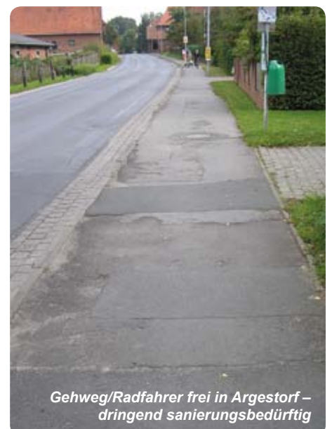
Schutzstreifen-Ende Degerer Straße vor dem Umbau
