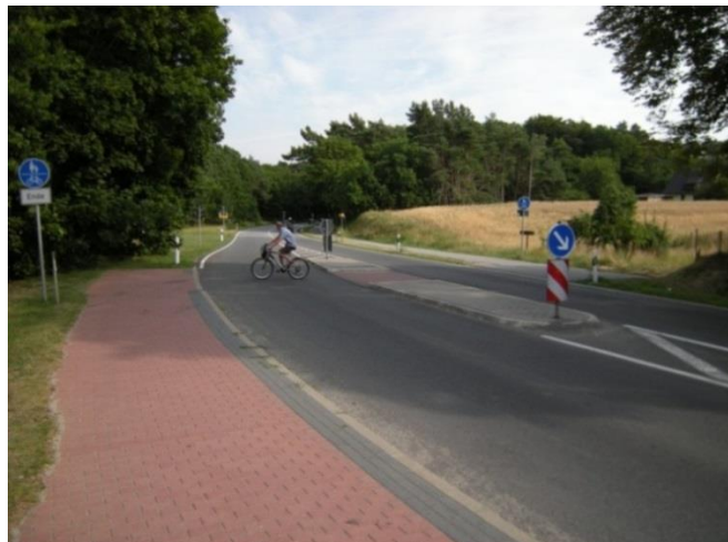
Abb. 4.10: Mittelinsel als Überquerungshilfe zur Anbindung eines außerörtlichen Zweirichtungsradweges (Foto A. Moeller)
