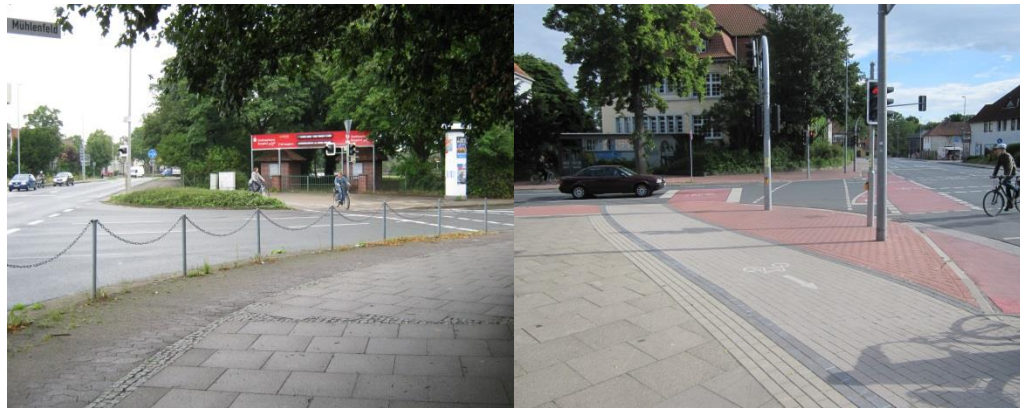
Abb. 4.11: Verbesserte Sicht durch Rückbau abgesetzte Furt (Burgdorf, Vor dem Celler Tor/Im Langen Mühlenfeld)
