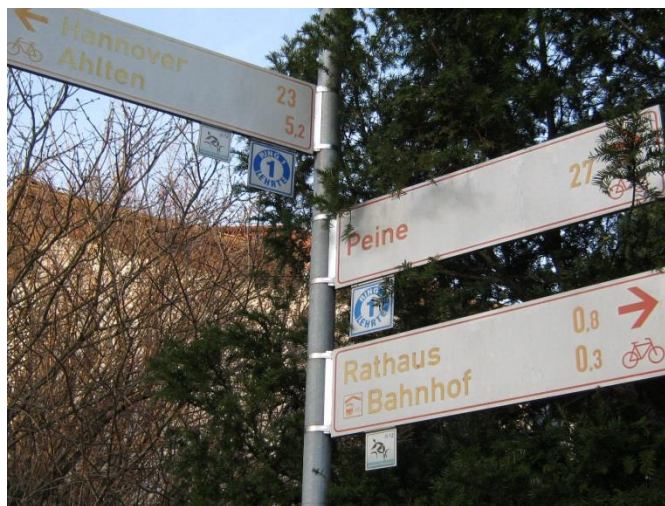
Abb. 4.8: Wegweisung mit Erneuerungsbedarf
