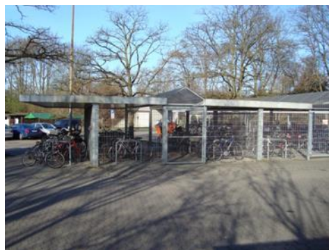
Abb. 4.14a: Fahrradgarage mit überdachten Abstellplätzen (Burgwedel)
