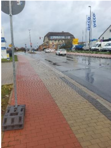
Abb. 40: Neuwertiger Wegeabschnitt eines gemeinsamen Geh- und Radweges (Degerser Str.)
