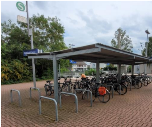
Abb. 61: Überdachte Fahrradabstellanlagen am S-Bahnhof Wennigsen (Deister)
