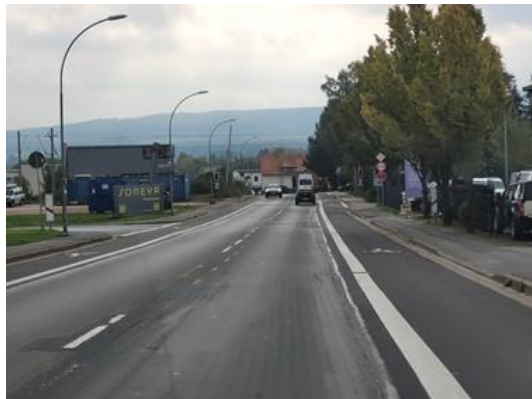
Abb. 20: Radfahrstreifen an der Degerser Straße
